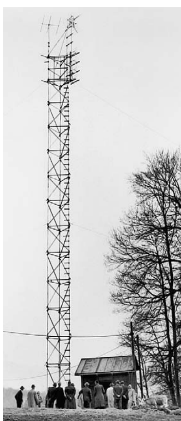
Erster Sendemast. Vor 50 Jahren ging auf St. Chrischona Basels erster Sender in Betrieb. Foto Keystone
